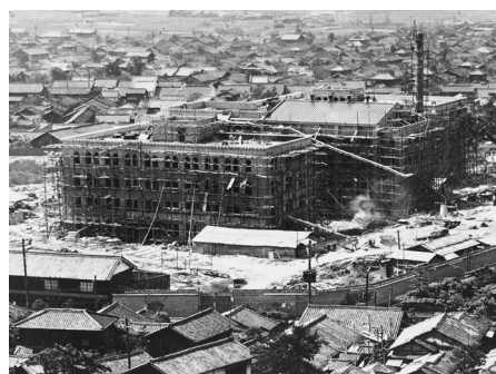
和歌山城天守閣から見た建設中の県庁舎
